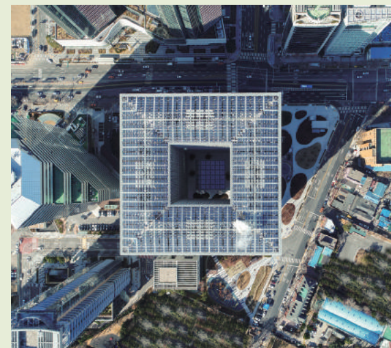
아모레퍼시픽 신본사 옥상 태양광 패널
